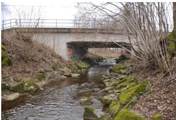
Abbildung 3-16: Bahndurchlass für den Nußbach (westlich der Bahn)
