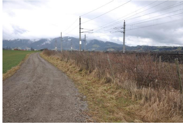
Abbildung 3-21: Zäunung entlang der Bahn bei Nußbach Süd
