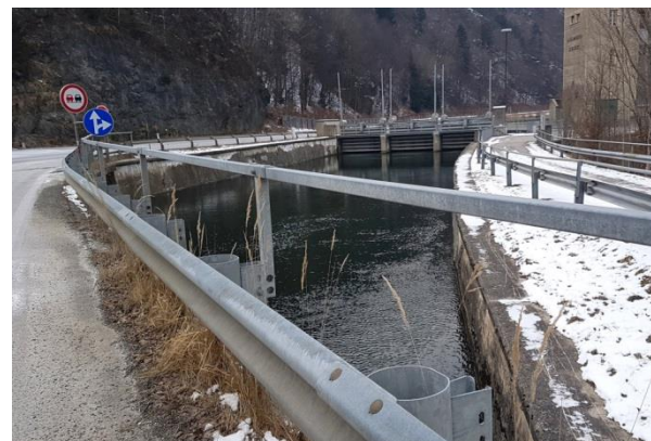
Abbildung 3-26: Harte Uferverbauung am Murkanal bei Zlatten in Pernegg an der Mur
