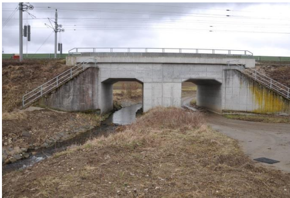
Abbildung 3-12: Zweigeteilter Bahndurchlass für Schwaigerbach und Straße bei Lambach
