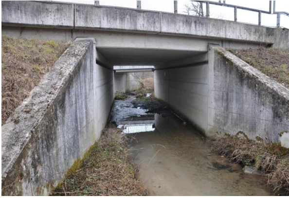
Abbildung 3-20: Bahndurchlass bei Nußbach Süd (östlich der Bahn)
