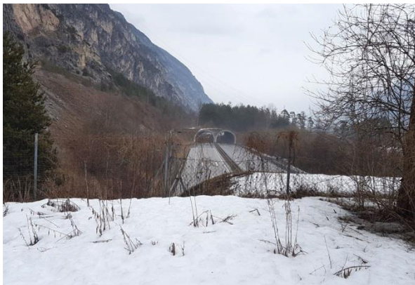
Abbildung 3-29: Blick von der WTP Kat. C zur WTP Kat. A in Richtung Osten
